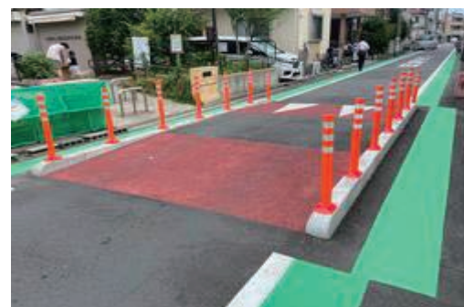
ハンプとポールによる物理的な速度抑制の一例。（神奈川県横浜市の事例）
