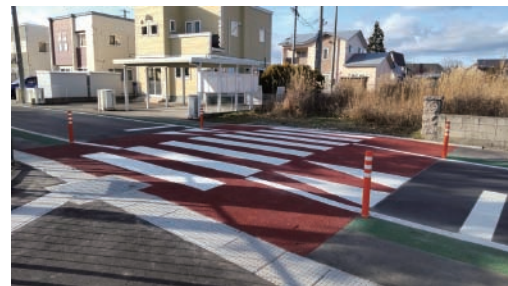
ゾーン30プラスで使用されるスムーズ横断歩道の一例。カラー舗装されたハンプに横断歩道が設置されています。（青森県むつ市の事例）
